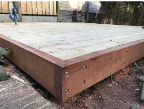
Hardhouten ringbalk met piketten inclusief houten vloer
