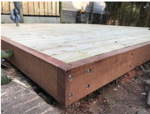
Hardhouten ringbalk met piketten inclusief houten vloer
