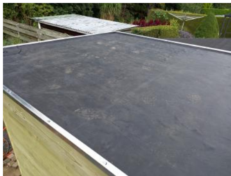
Epdm dak rubberfolie
