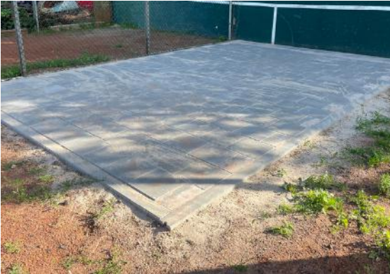
Opsluitbanden met bestrating
